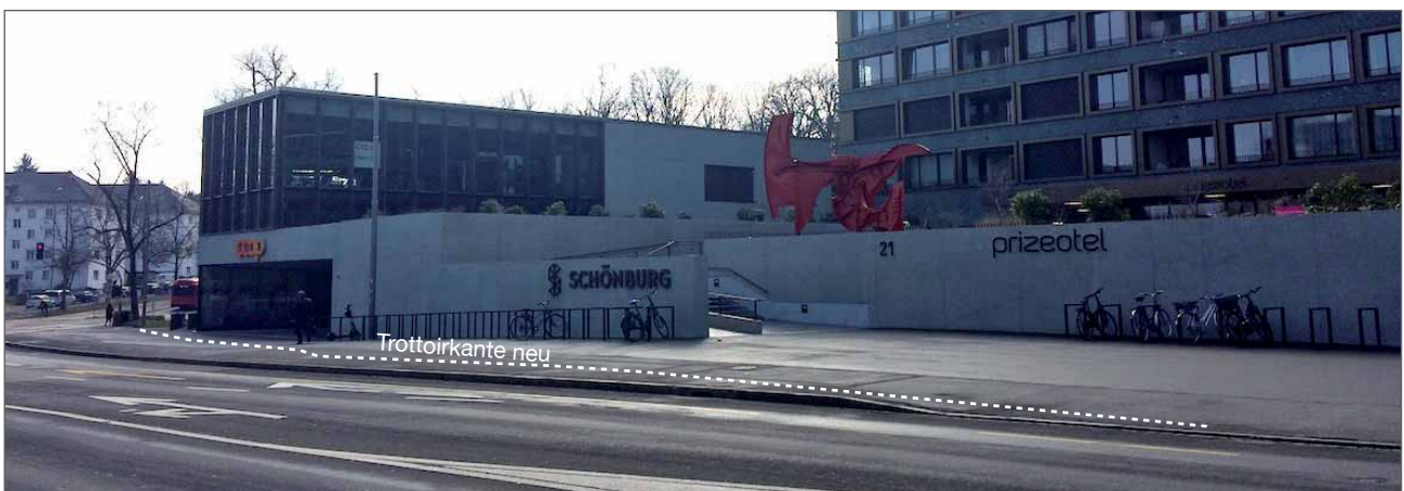
Foto mit Situation Schönburg, Zugang Coop. Das Trottoir wird stark verschmälert und der Fussgänger an den Rand gedrückt.
