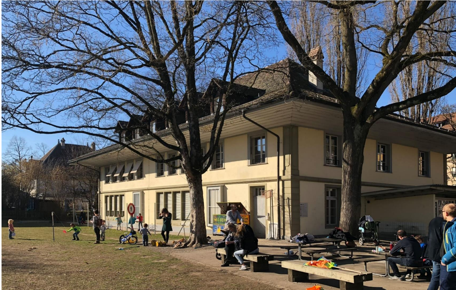
Heutiger Zustand Süd-Ostfassade & Aussenraum
