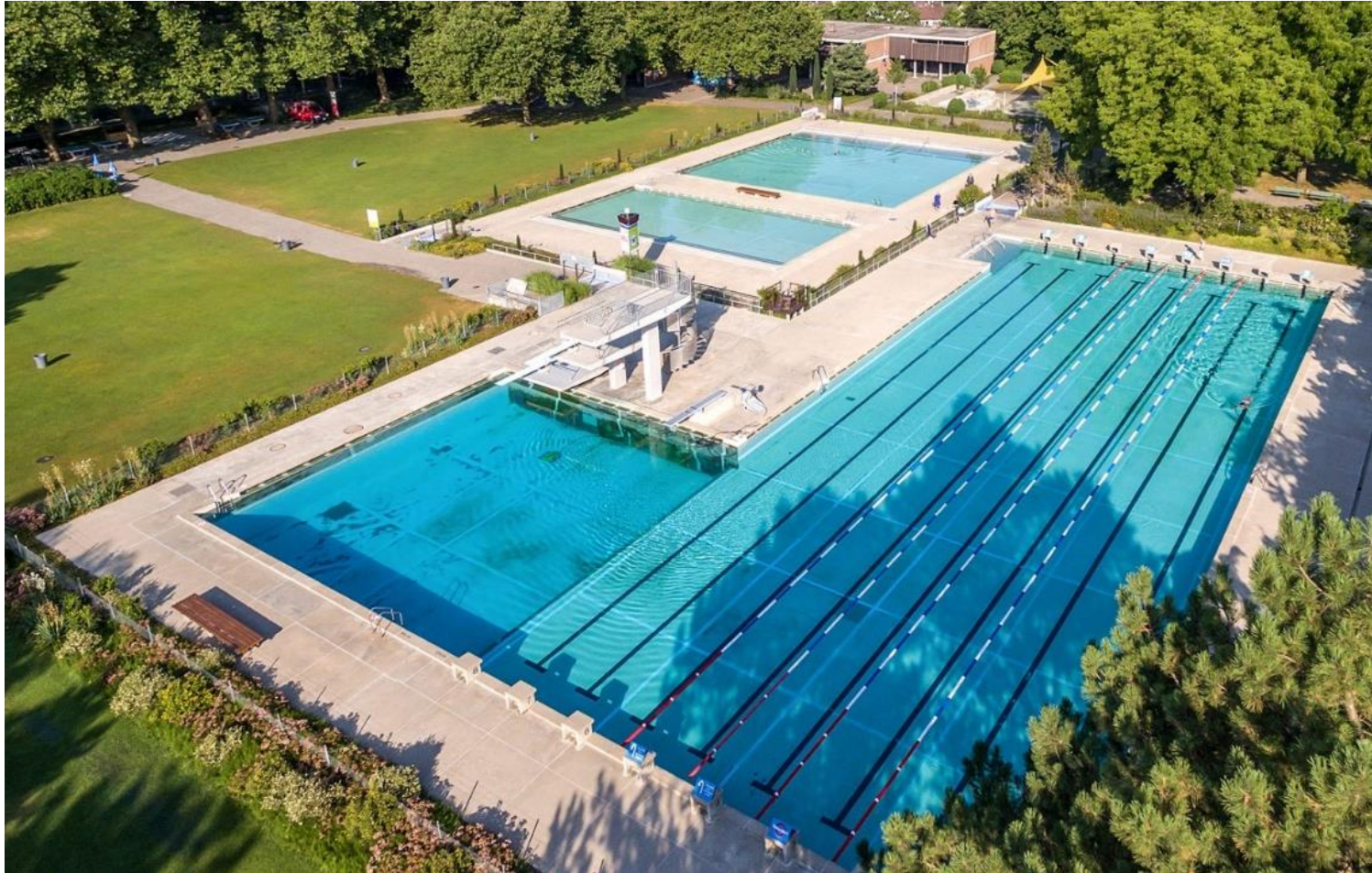
Heutiger Zustand Aussenbeckenanlage
