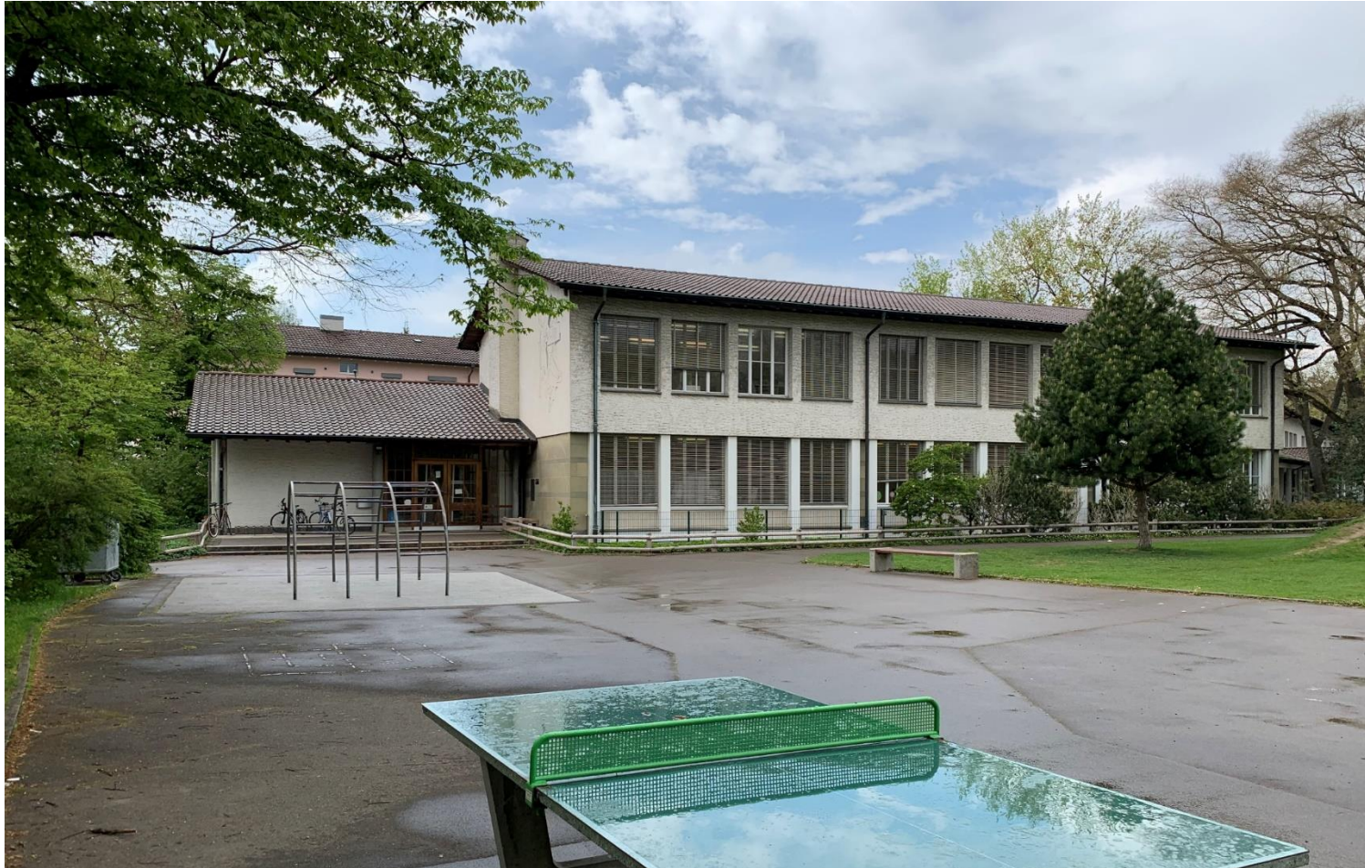
Heutiger Zustand Hauptgebäude Weingartstrasse18
