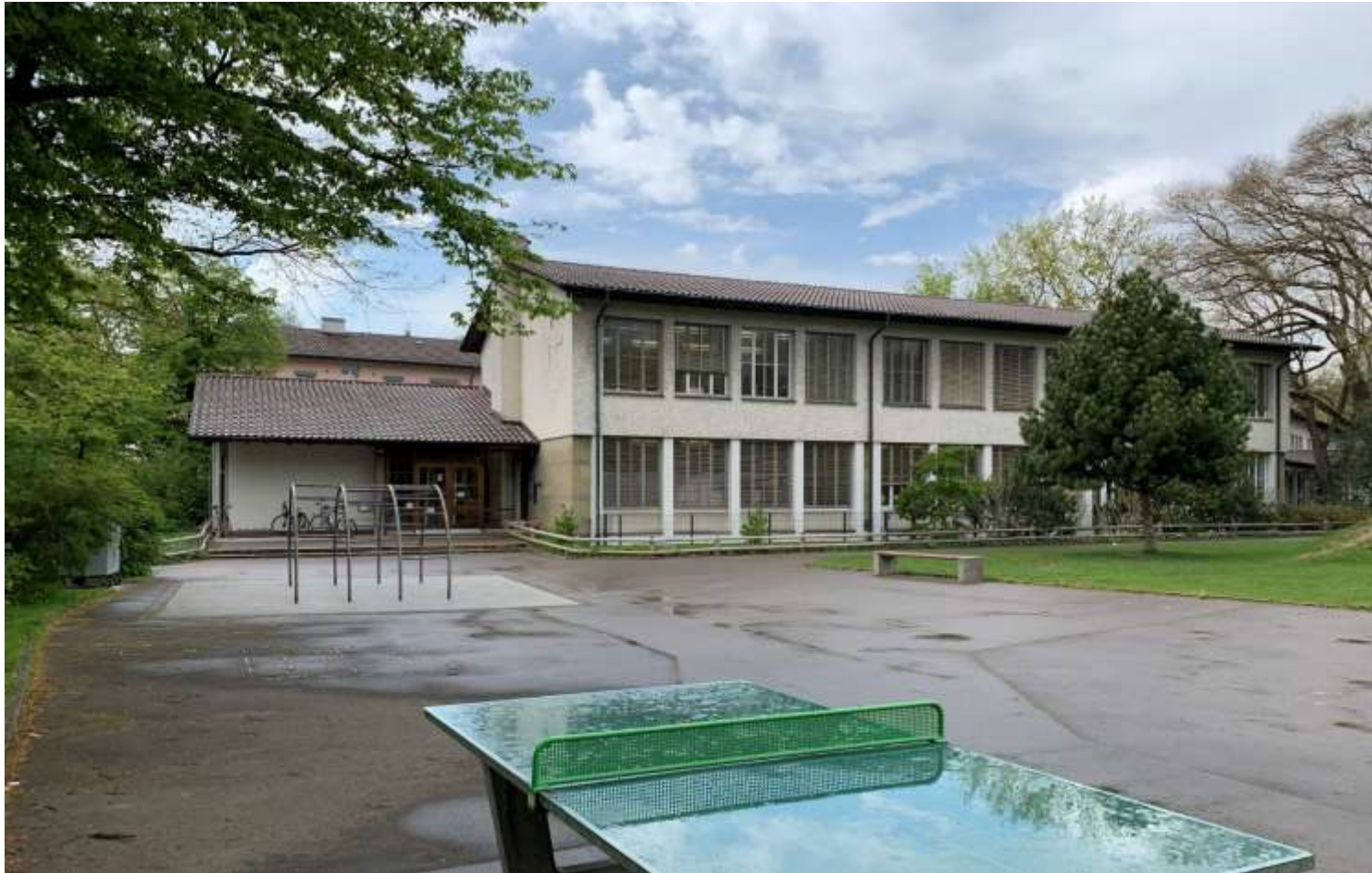
Heutiger Zustand Hauptgebäude Weingartstrasse18
