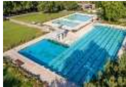
Freibad Wyler Sanierung Freibad Phase: Auswahlverfahren Bauende: 2024
