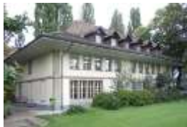
Volksschule Steckgut Gesamtsanierung Projektphase: Projektierung Bauende: 2023
