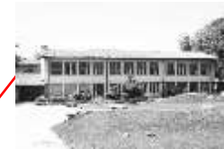
Volksschule Markus Gesamtsanierung Projektphase: Projektierung Bauende: 2022
