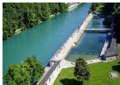
Freibad Lorraine Gesamtsanierung Projektphase: Projektierung Bauende: 2025
