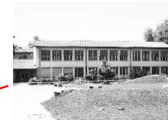
Volksschule Markus Gesamtsanierung Projektphase: Realisierung Bauende: 2022
