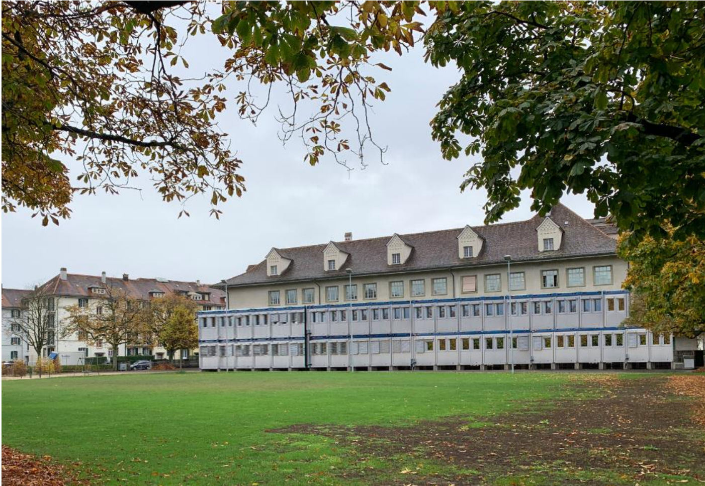
Provisorium Schulhaus Breitfeld
