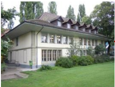
Volksschule Steckgut Gesamtsanierung Projektphase: Projektierung Bauende: 2023
