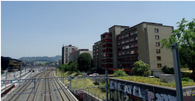
Foto von der Brücke Scheibenstrasse/ von Norden
