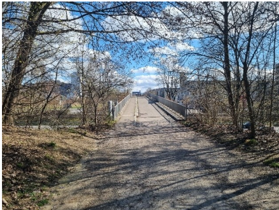
Abb. 4.11 Übergang von der Grossen zur Kleinen Allmend, Brücke über die Autobahn 12.03.2026 – Quelle: SKK
