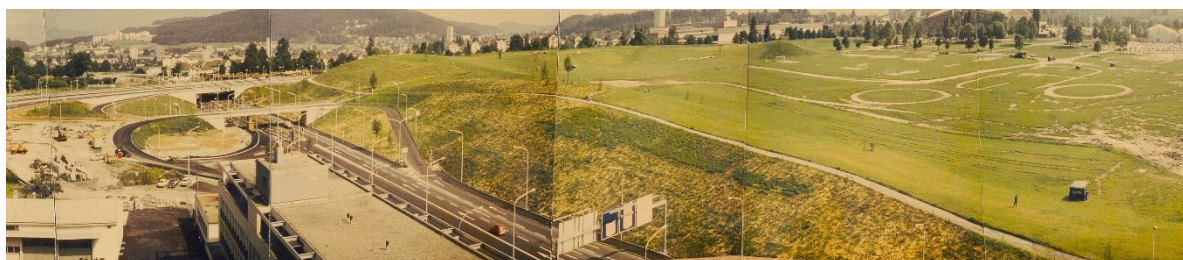
Abb. 3.2 15. Mai 1973, Fertigstellung der Autobahn mit seinem Geländeschnitt und der Modellierung der grossen Allmend vor der Pflanzung des Grüngürtels
